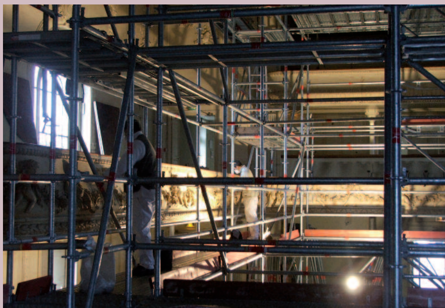
LES ÉCHAFAUDAGES POUR LA RESTAURATION DES DÉCORS EN STAFF DE LA GALERIE ET LA RÉFECTION DE LA SALLE
