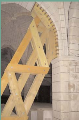
À GAUCHE, VUE DU BAS-CÔTÉ MÉRIDIONAL DÉFORMÉ PAR LA POUSSÉE DU CLOCHER ; À DROITE, UN CINTRE A ÉTÉ INSTALLÉ CONTRE LE PILIER DE LA TROISIÈME TRAVÉE AFIN DE PRÉVENIR DES NOUVELLES DÉFORMATIONS
