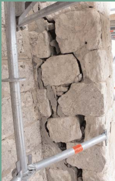
DISJONCTION DES MAÇONNERIES DE L'UN DES CONTREFORTS DU CLOCHER
