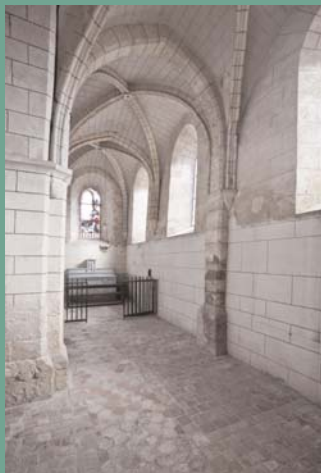
À GAUCHE, VUE DU BAS-CÔTÉ MÉRIDIONAL DÉFORMÉ PAR LA POUSSÉE DU CLOCHER ; À DROITE, UN CINTRE A ÉTÉ INSTALLÉ CONTRE LE PILIER DE LA TROISIÈME TRAVÉE AFIN DE PRÉVENIR DES NOUVELLES DÉFORMATIONS
