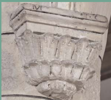
CUL DE LAMPE FEUILLAGÉ PORTANT LA DATE DE 1616 GRAVÉE SUR LE TAILLOIR
