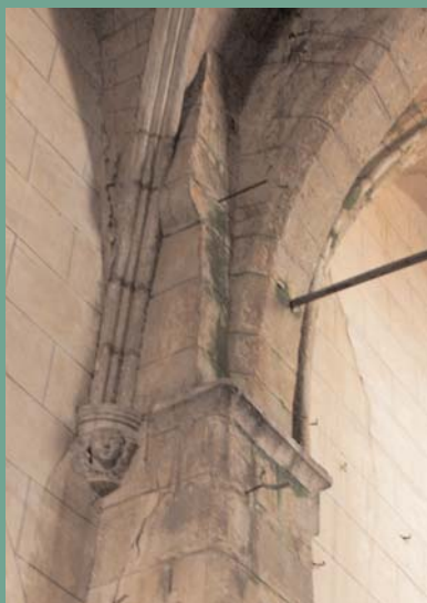
INFILTRATION D'EAU AU NIVEAU DE L'ARC DOUBLEAU DE LA TROISIÈME TRAVÉE DU CHOEUR
