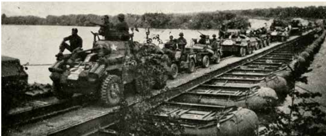
Fig. 10 - Pont flottant construit par la 3 e armée du général Patton entre Saint-Fargeau et Seine-Port pour franchir la Seine. Il s'agit du « pont provisoire de bateaux gonflés » décrit par Suzette Thierry ou le « pont en caoutchouc » noté par Irène Charton (AD77, AZ5220)
