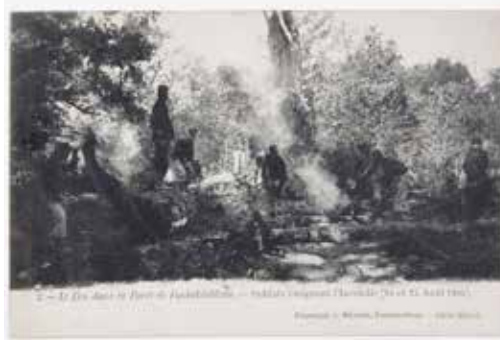
Deux cartes postales anciennes représentant l'incendie du 15 août 1904 en forêt de Fontainebleau
