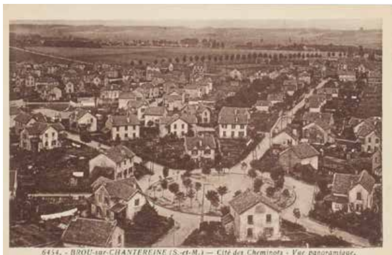
Fig 3.b : Vue panoramique de la cité des cheminots de Brou-sur-Chantereine, Archives départementales de Seine-et-Marne
