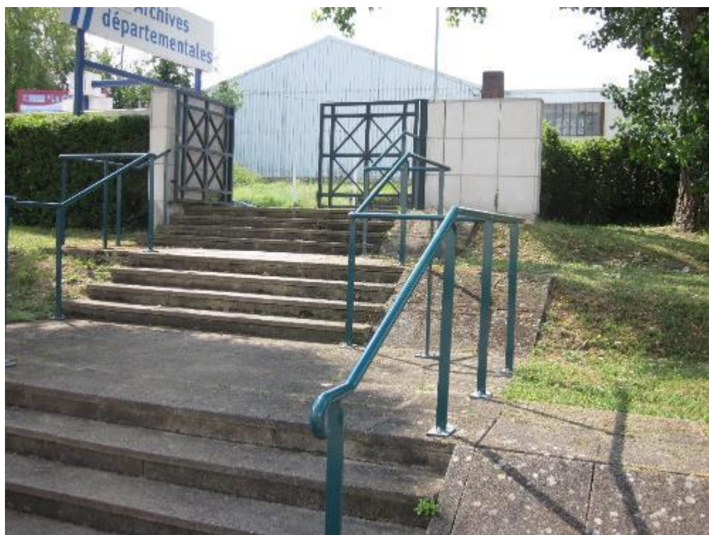
Rampe continue de l'escalier extérieur menant du trottoir vers la porte d'entrée des Archives départementales
