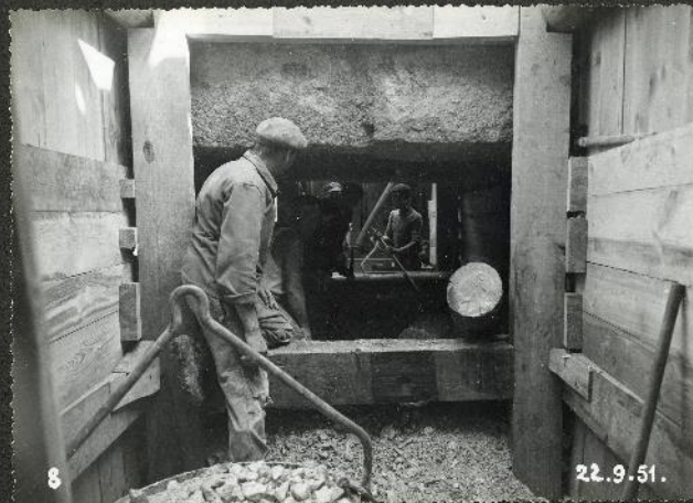
FOUILLE en SOUS-ŒUVRE
