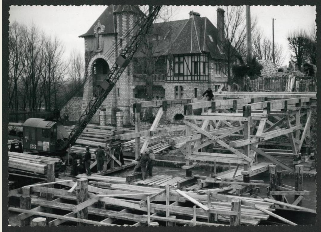
Avancée de la construction du pont
