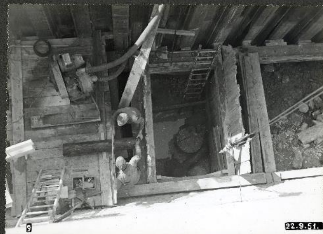
RÉAJUSTEMENT d'UN BATAURFAU
