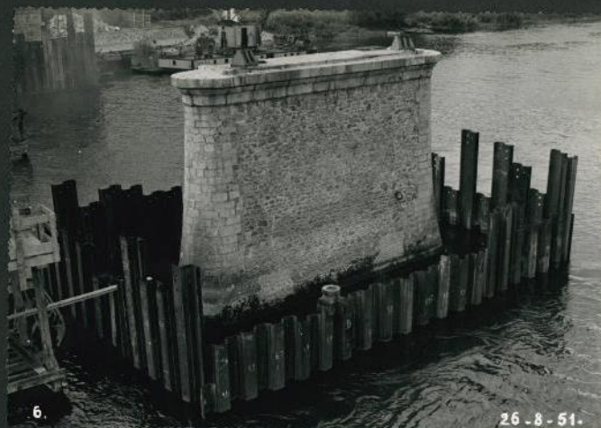
BATARDEAU de la PILE de DROITE, TERMINÉ
