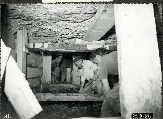
FOUILLE en SOUS-ŒUVRE
