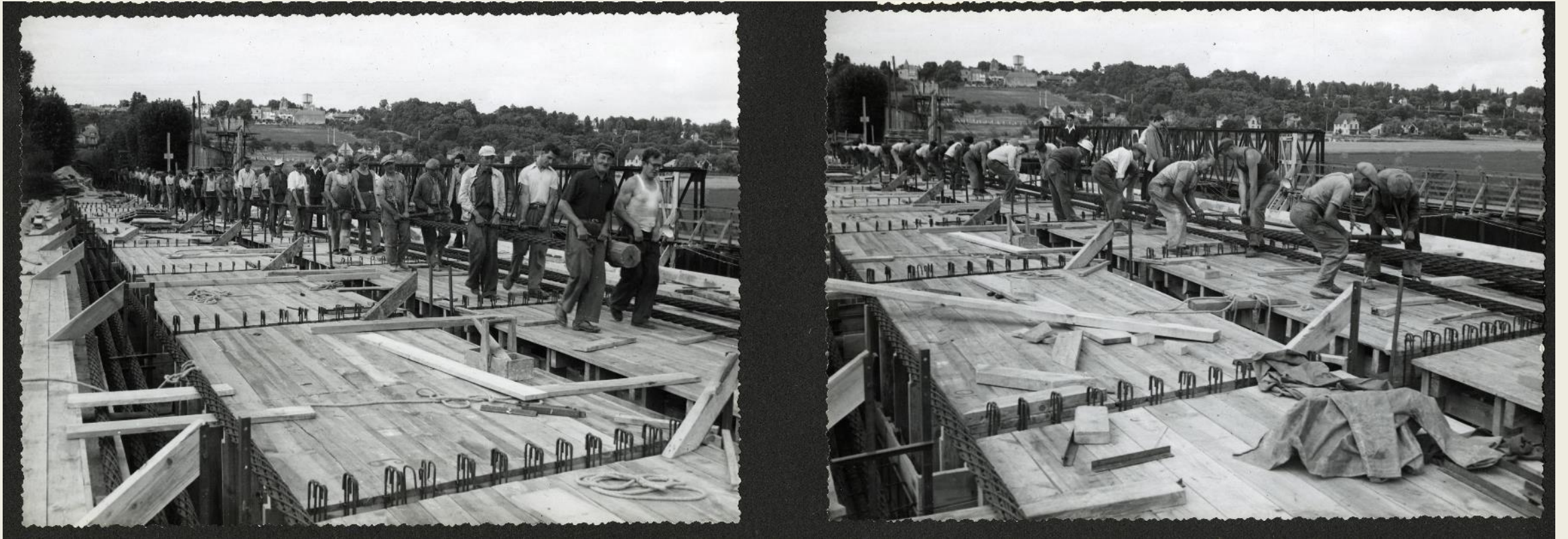
Transport des armatures pour mise en place dans les coffrages
