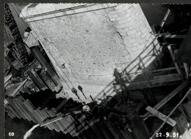
FOUILLE en SOUS-ŒUVRE
