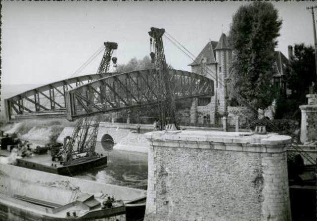
ENLEVEMENT de la DERNIERE TRAVÉE de l'ANCIEN COUVREGE
