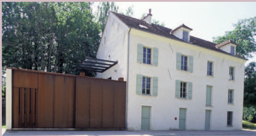
L'ÉDIFICE APRÈS RESTAURATION, LA PARTIE MODERNE FERMÉE PAR UN VOLET EN MÉTAL CORTEN
