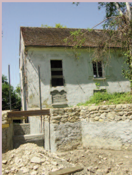
AU DESSUS : LE BIEF SANS EAU PENDANT LES TRAVAUX A GAUCHE : REPRISE ET NETTOYAGE DU BIEF
