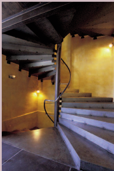
L'ESCALIER À VIS INSTALLÉ DANS LA QUATRIÈME TRAVÉE.
