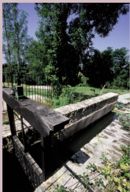
LA VANNE D'ALIMENTATION DE LA ROUE ET LE CANAL D'AMENÉE
