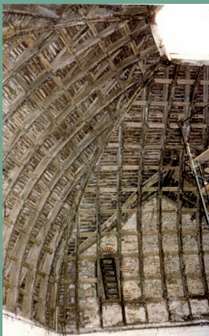
RESTAURATION DE LA CHARPENTE EN 1986
