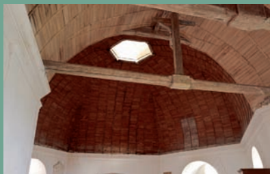
VUE DE LA ROTONDE DEPUIS LE CHOEUR : AU PREMIER PLAN, LES ENTRAITS DU CHOEUR SONT VISIBLES
