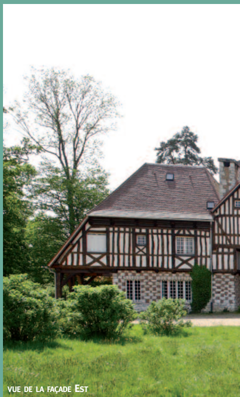
VUE DE LA FAÇADE EST
