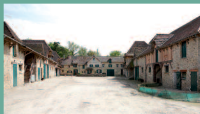
COUR INTÉRIEURE DE LA FERME AUJOURD'HUI
