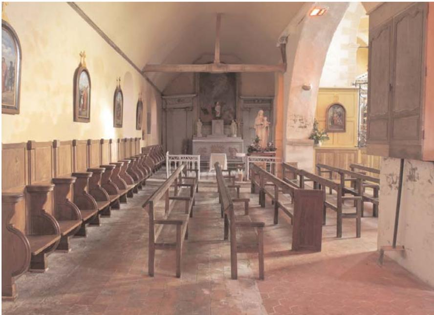
LE BAS-CÔTÉ EST COUVERT D'UN PLAFOND À SOUPENTES LAISSANT LES ENTRAITS ET LES POINÇONS APPARENTS
