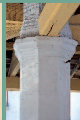
DÉTAIL DE L'UN DES QUATRE PILIERS DE PIERRE SUPPORTANT LE LANTERNEAU CENTRAL
