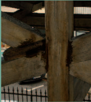
DÉSORDRES DE LA CHARPENTE DUS À DES INFILTRATIONS D'EAU (AVANT RESTAURATION)
