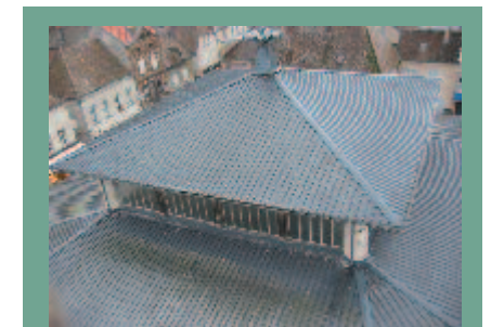
LA COUVERTURE DE LA HALLE, INITIALEMENT EN ARDOISE, REMPLACÉE CONFORMÉMENT AU PROJET D'ORIGINE, PAR UNE COUVERTURE EN ZINC EN 1882, A ÉTÉ RÉALISÉE EN BAC ACIER DANS LES ANNÉES 1990. (LE CLICHÉ EST ANTÉRIEUR À LA RESTAURATION DE LA HALLE, LE LANTERNEAU N'EST PAS ENCORE RESTAURÉ).
