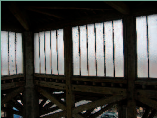
DÉSORDRES DE LA CHARPENTE DUS À DES INFILTRATIONS D'EAU (AVANT RESTAURATION)
