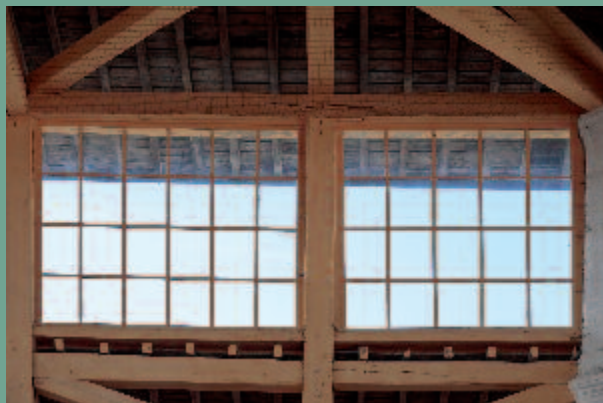
LES VERRIÈRES DU LANTERNEAU AVANT RESTAURATION
