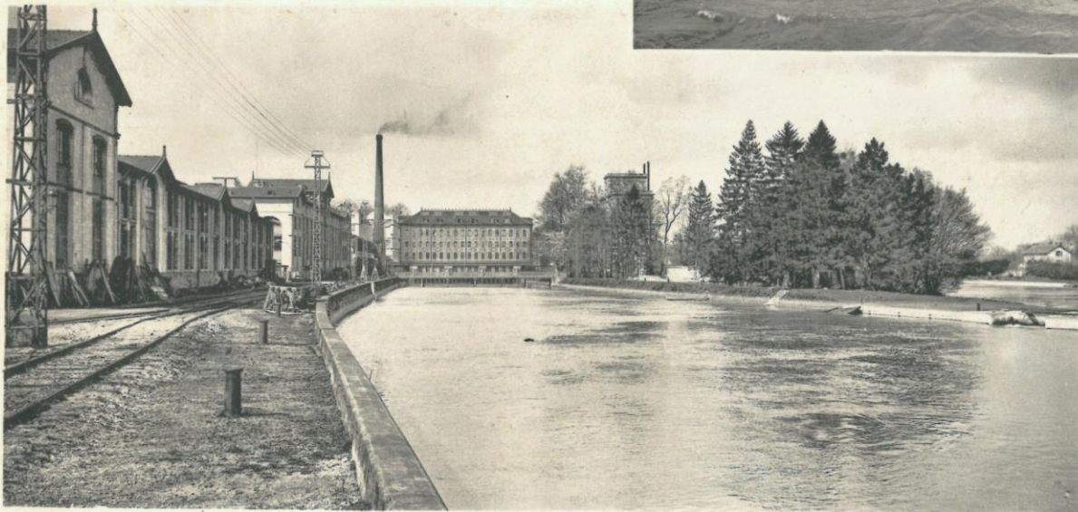
VUE DE L'USINE EN AMONT
