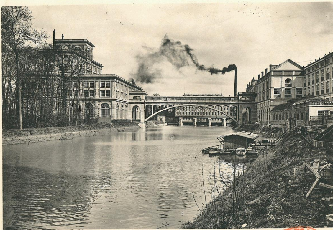
VUE DE L'USINE EN AVAL
