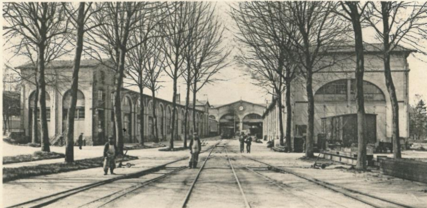
COUR D'ARRIVÉE DU CHEMIN DE FER DE L'USINE
