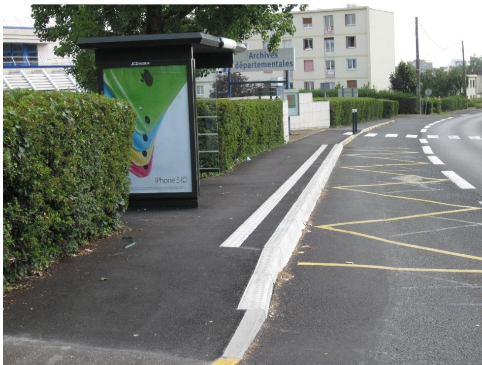
Arrêt de bus surélevé permettant aux personnes en fauteuil d'accéder au trottoir devant les Archives départementales
