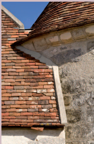
JOINTURE ENTRE LE CHEVET ET LA ROTONDE
