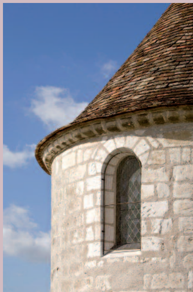
BAIE EST DE LA ROTONDE
