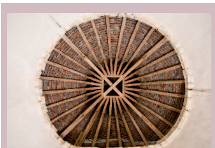
CHARPENTE DE LA ROTONDE
