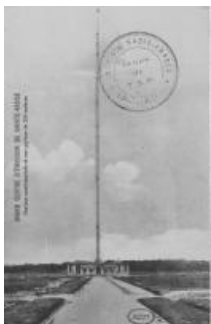
Un des onze mâts de 250 mètres de haut du centre radioélectrique. Carte postale de Seine-Port, XXe siècle (AD77, 2Fi7832)
