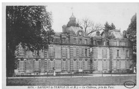
Carte postale du château de La Grange-la-Prévôté à Savigny-le-Temple (AD 77, 2 Fi 7767)
