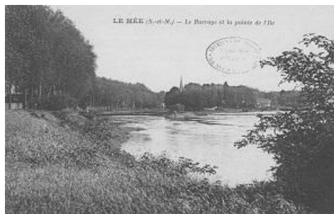
Vue du barrage et de la pointe de l'île du Mée-sur-Seine, ville où vit Pierre-Simon de Laplace de 1793 à 1799. Carte postale du Mée-sur-Seine, XXe siècle. (AD77, 2FI4672)
