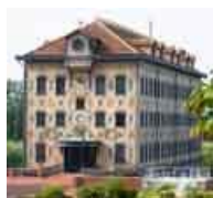
L'usine Menier à Noisiel, de nos jours. (Cliché : Conseil Départemental de Seine-et-Marne)
