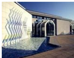
Entrée du bâtiment
