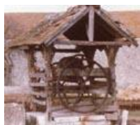
Puits à Bésigny, près de Souppes-sur-Loing (diapositive de la malle "Habitat rural")
