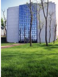
La tour de conservation des Archives départementales de Seine-et-Marne
