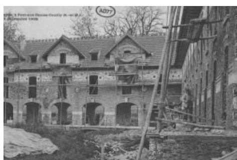
Maison de retraite des artistes dramatiques, en travaux avant l'ouverture. On aperçoit la façade Art nouveau et ses sculptures. Carte postale de Couilly-Pont-aux-Dames, 1903. (AD77, 2F19595)
