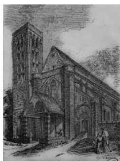
Façade de la collégiale Saint-Martin de Champeaux (AD77, 2Fi800)
