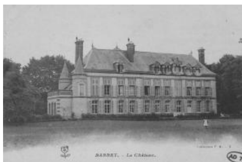
Vue de la façade du château de Barbey, réalisé en pierres et briques avec une toiture en ardoises. Carte postale de Barbey, 1910 (AD77, 2F117998).
