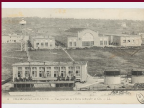
Vue des usines Schneider à Champagne-sur-Seine, carte postale, [1910] (AD77, 2F119626) © Archives départementales de Seine-et-Marne
